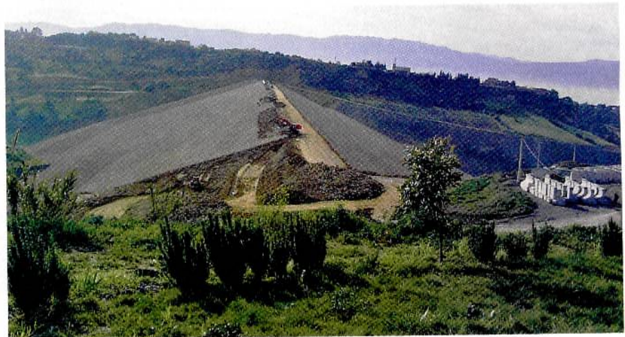
ΜΕΛΕΤΗ ΕΦΑΡΜΟΓΗΣ και επίβλεψη των εργασιών για την κατασκευή του φράγματος Douera στην Αλγερία, ένα πρότζεκτ της εταιρείας ENB.
