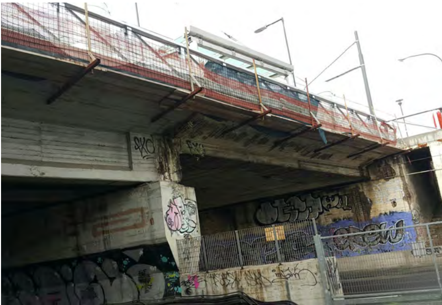
Εικόνα 3. Γέφυρα Γρηγορίου Λαμπράκη.
