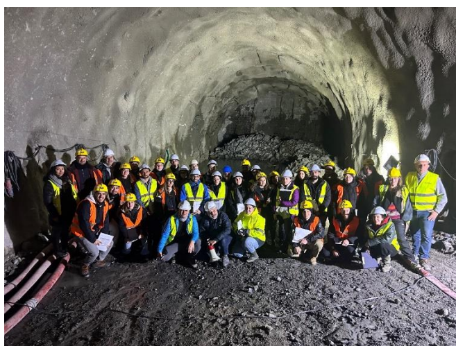
Έργα του συστήματος αντλησιοταμίευσης Αμφιλοχίας
