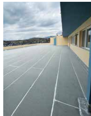
Μόνωση ταράτσας με ασφατικές μεμβράνες: πριν (πάνω) και μετά (κάτω).
