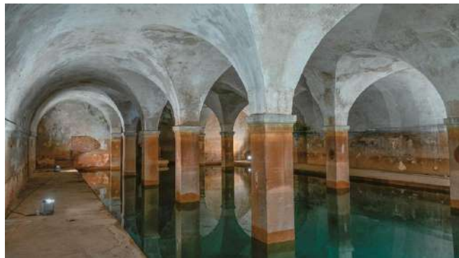
και η δεξαμενή του Αδριανού, στο Κολωνάκι.
